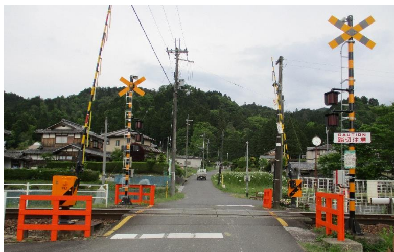
西園寺第二踏切 保安装置更新
